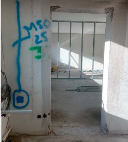
Eine neue Tür entsteht und aus einem Raum werden zwei gemacht.
