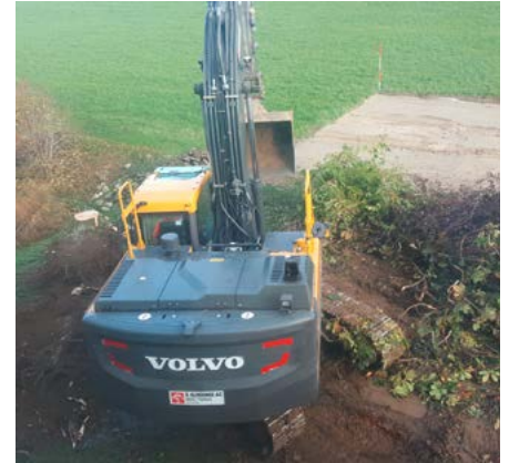
Aushubarbeiten mit schwerem Gerät.
