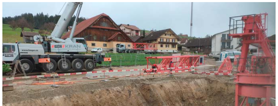
Stellen des Krans.
