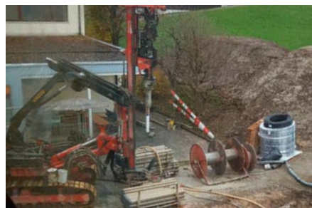
Erdsondenbohrung.
