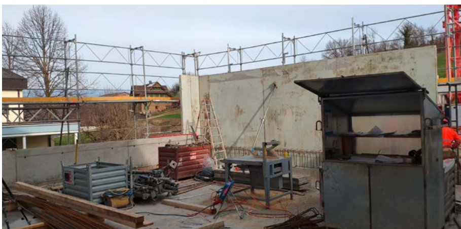
Entstehen des Untergeschosses.
