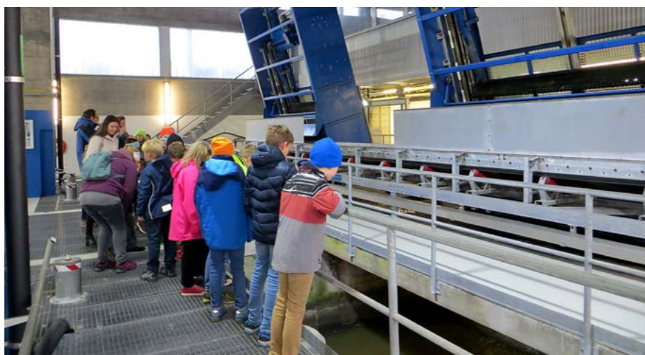
Die Rechenanlage entfernt Grobstoffe.
